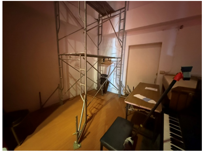
中正堂舞台防水修補
