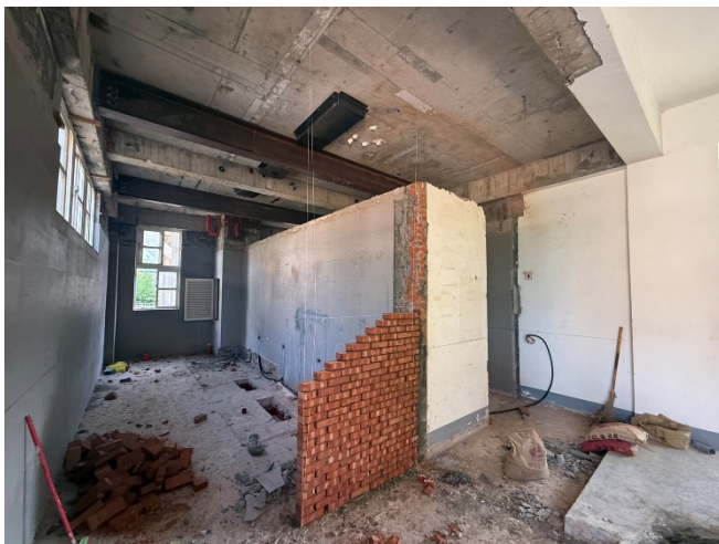
行政大樓西側廁所整修工程砌磚
