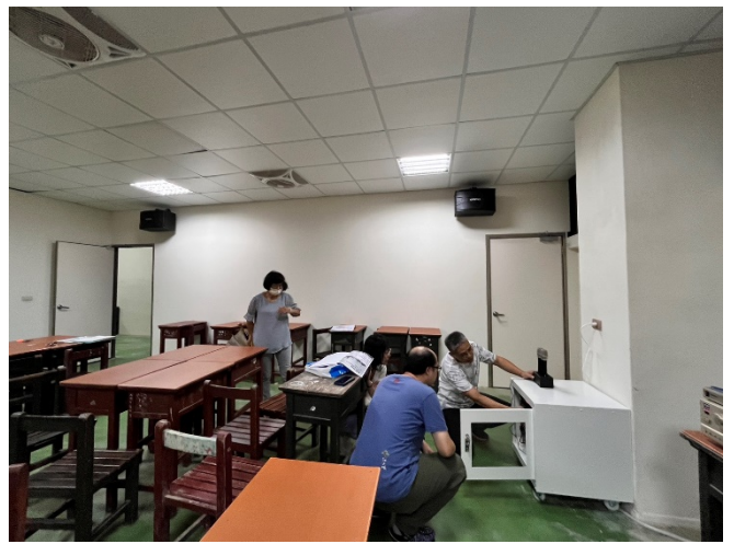
中正堂地下室音響設備
