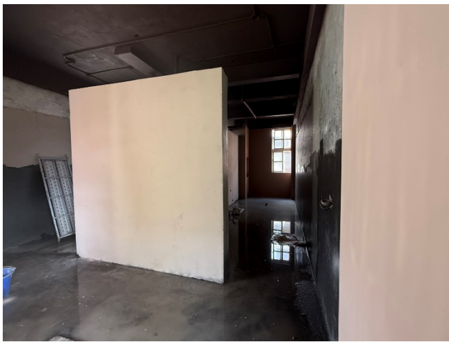
行政大樓西側廁所整修工程試水
