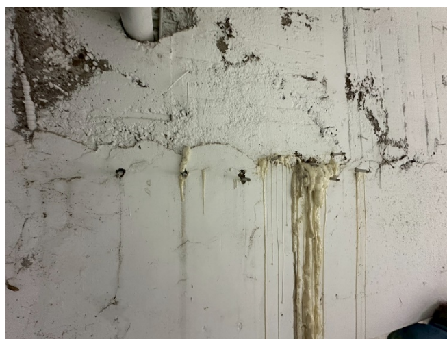
114 年校園建築物局部防水工程採購案 (發泡止漏劑灌注)
