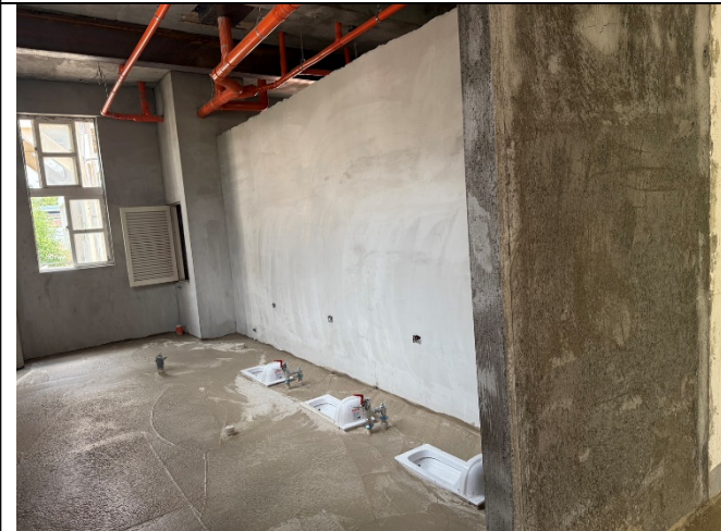
行政大樓西側廁所整修泥作工程
