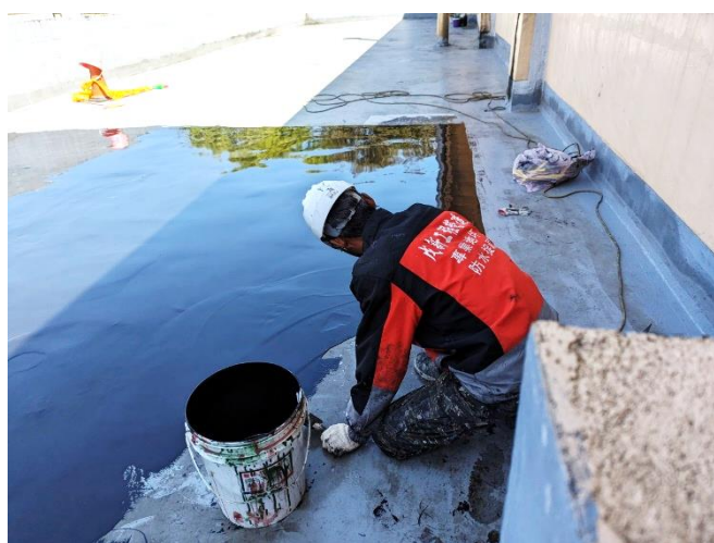
茶工廠漏水施工
