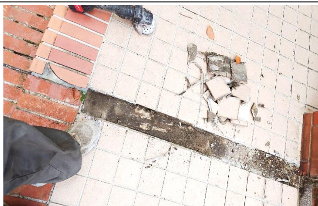
圖書館通道磁磚施工中
