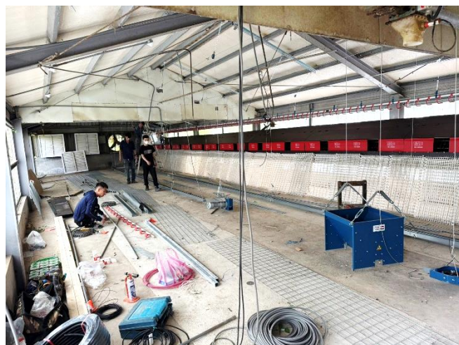
蛋雞舍整建施工中
