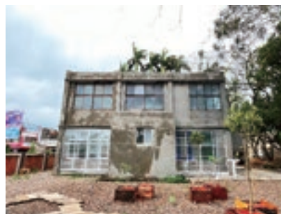
資源回收室後方（施工後）
