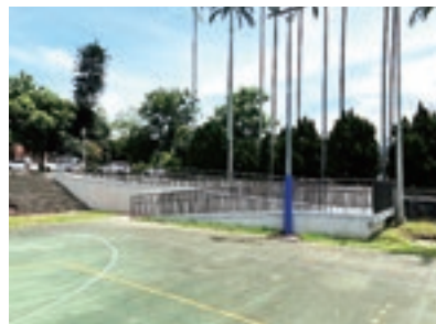
無障礙坡道（改善後）
