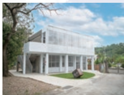
資源回收室正面照（施工後）
