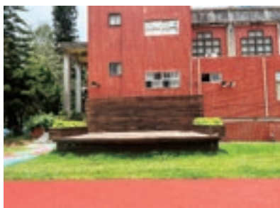
中正堂樂活舞台拆除
