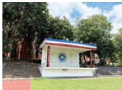
電力線路重整、重新上漆
