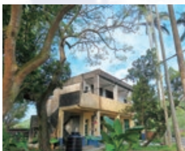
資源回收室正面照（施工前）
