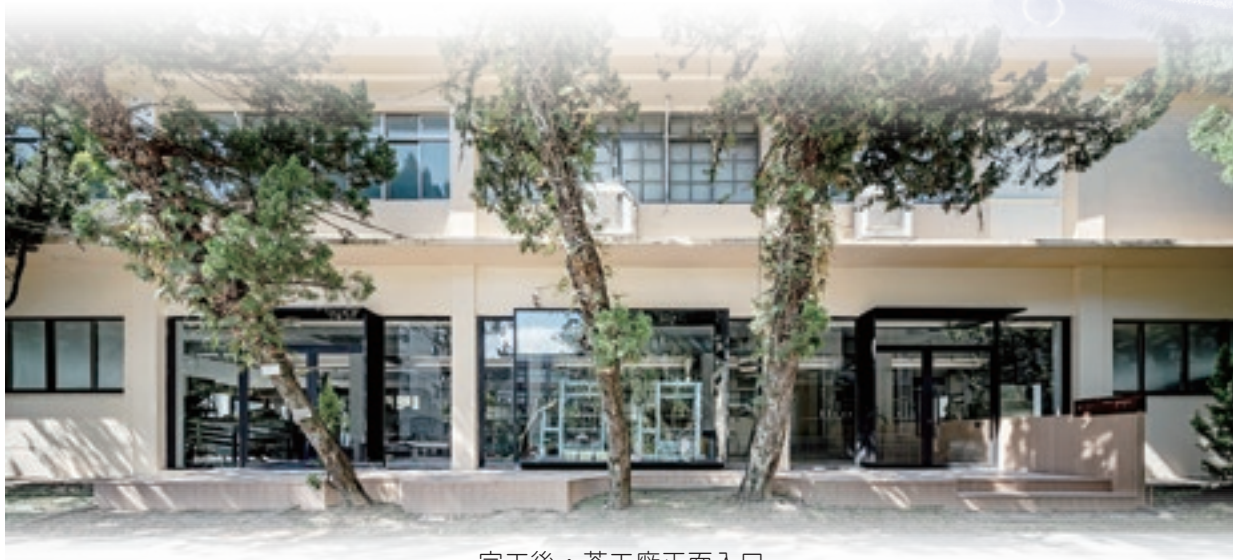
完工後，茶工廠正面入口
