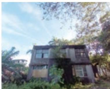
資源回收室後方（施工前）
