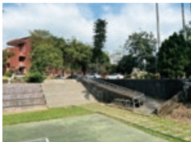
舊有坡道坡度過陡過窄
