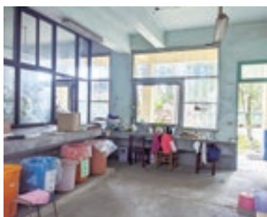
資源回收室 1 樓（施工前）
