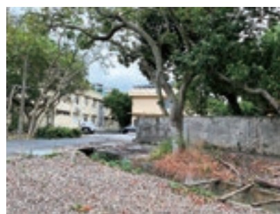
資源回收室 1 樓東側邊（施工後）
