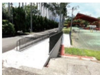
無障礙坡道（改善後）
